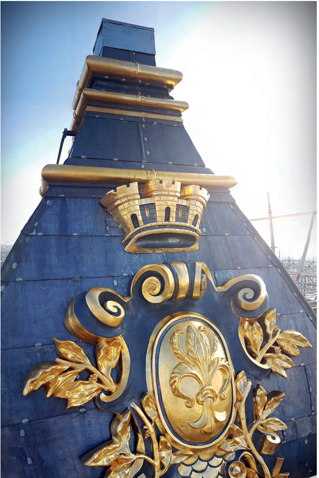
Détail de la toiture du palais des Beaux-Arts de Lille.
