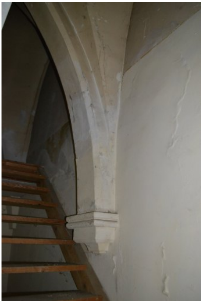
Fig. 67 - Chapelle, avant restauration, départ d'un arc.
