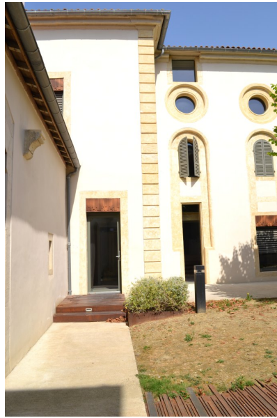
Fig. 62 - Aile ouest, élévation sur cour, vue depuis le sud-est (après restauration).
