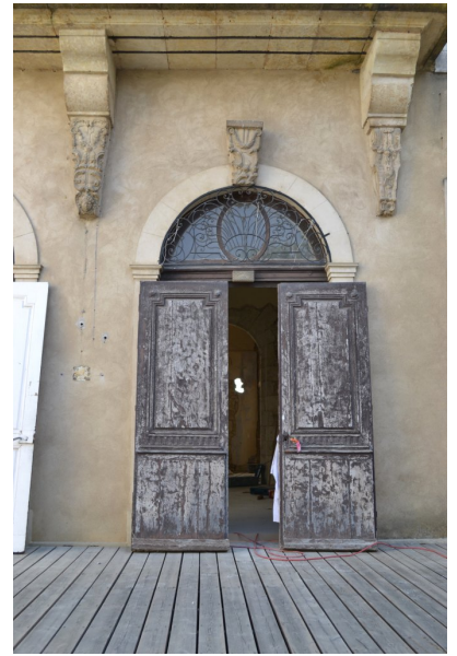
Fig. 12 - Logis, façade sur cour, détail d'une des portes d'entrée (travaux en cours).
