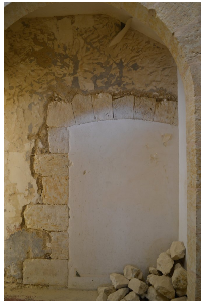
Fig. 53 - Logis, étage de soubassement, porte bouchée (travaux en cours).
