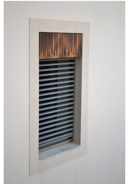
Fig. 72 - Aile est, détail d'une fenêtre (après restauration).
