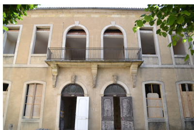
Fig. 8 - Logis, façade sur cour (travaux en cours).
