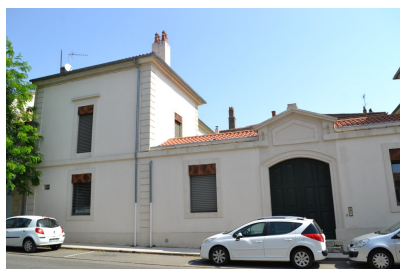
Fig. 2 - Façade sur rue, partie nord.
