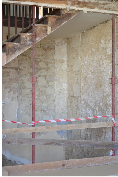
Fig. 56 - Logis, premier étage, escalier secondaire menant aux combles (travaux en cours).
