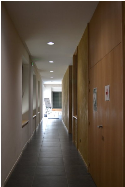
Fig. 73 - Aile est, rez-de-chaussée, vue du couloir (après travaux).
