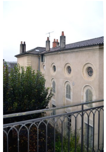
Fig. 60 - Vue de la chapelle depuis la chambre principale du 1er étage du logis (avant restauration).
