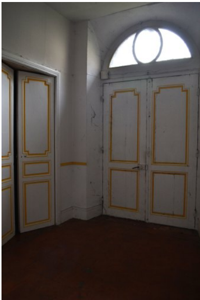
Fig. 25 - Logis, rez-de-chaussée, vestibule (avant travaux).
