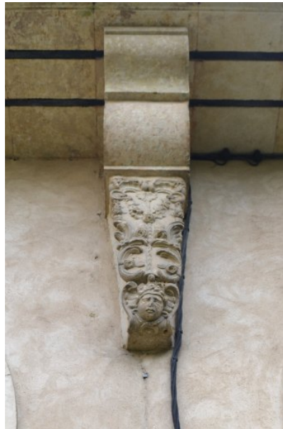
Fig. 14 - Logis, façade sur cour, détail d'une console sculptée.
