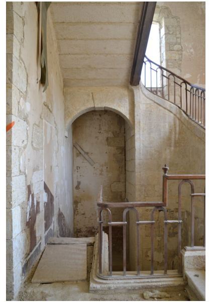
Fig. 36 - Logis, rez-de-chaussée, escalier d'honneur, volée descendant vers l'étage de soubassement (travaux en cours).
