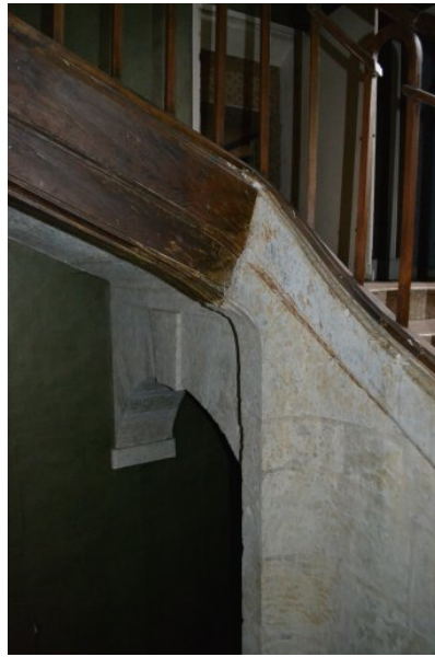
Fig. 44 - Logis, premier étage, escalier d'honneur, détail du limon (avant travaux).
