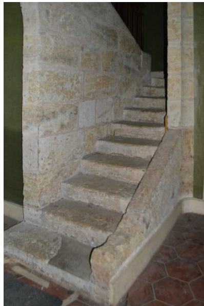
Fig. 38 - Logis, étage de soubassement, escalier d'honneur, départ (avant travaux).
