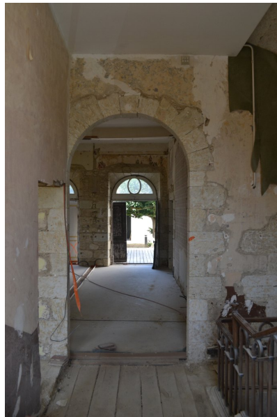
Fig. 32 - Logis, rez-de-chaussée, vue du vestibule depuis l'escalier d'honneur (travaux en cours).
