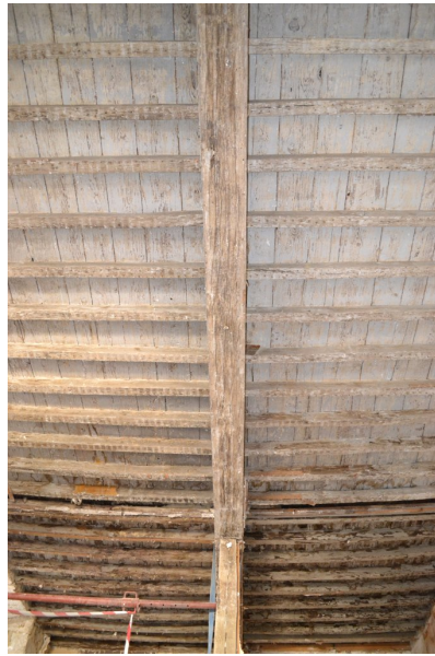
Fig. 29 - Logis, rez-de-chaussée, pièce à gauche du vestibule, détail du plafond (travaux en cours).
