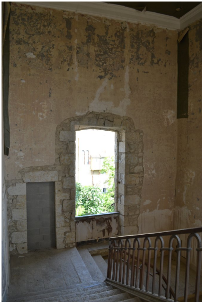
Fig. 46 - Logis, premier étage, escalier d'honneur (travaux en cours).
