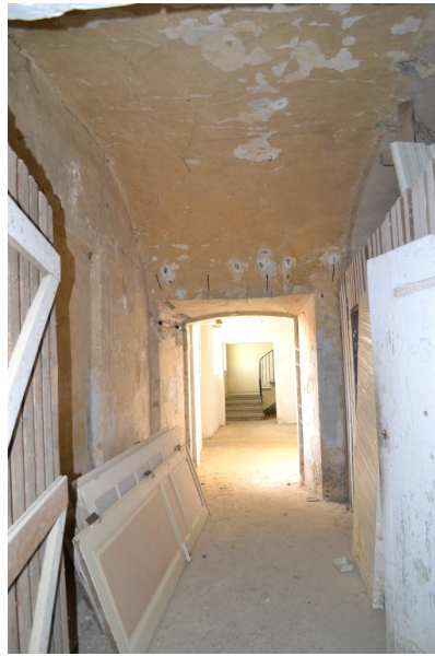
Fig. 50 - Logis, étage de soubassement, enfilade de caves (travaux en cours).
