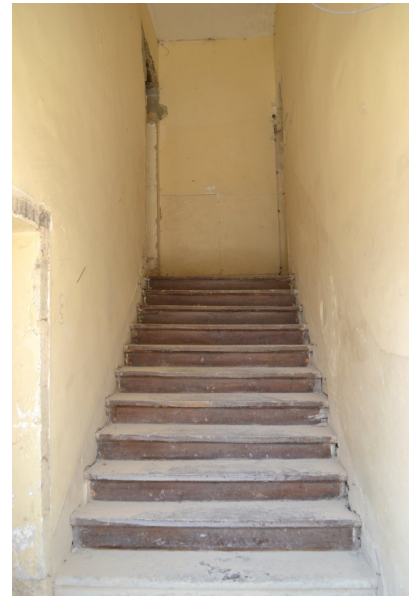
Fig. 48 - Logis, étage de soubassement, escalier donnant sur l'extérieur, vue depuis le bas (travaux en cours).
