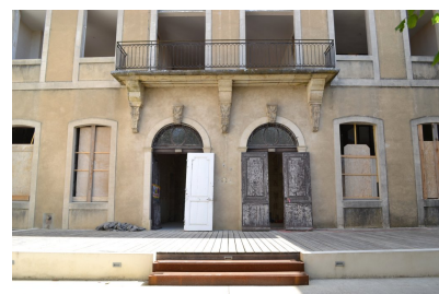
Fig. 9 - Logis, façade sur cour, détail du rez-de-chaussée (travaux en cours).
