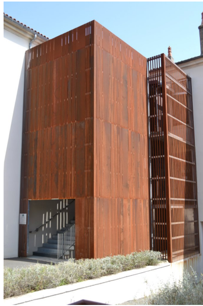
Fig. 77 - Nouvelle cage d'escalier et d'ascenseur, vue depuis le sud-est (après travaux).
