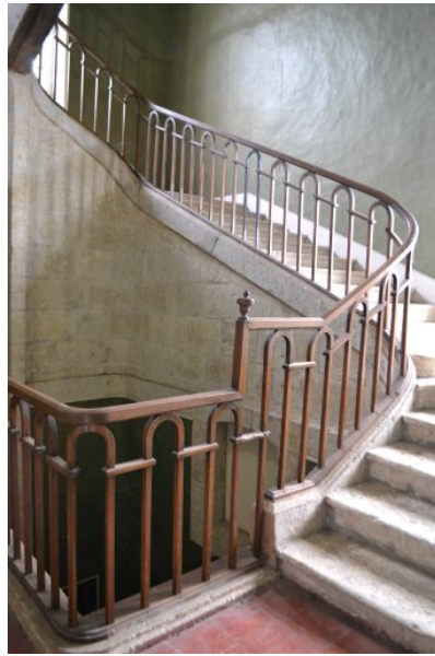
Fig. 35 - Logis, rez-de-chaussée, escalier d'honneur, vue du palier (avant travaux).
