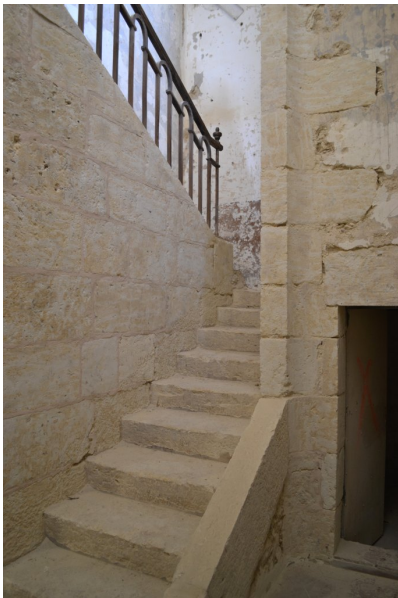
Fig. 37 - Logis, étage de soubassement, escalier d'honneur, départ (travaux en cours).
