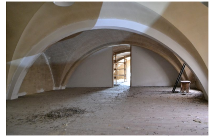
Fig. 66 - Chapelle, avant restauration, détail des voûtes.
