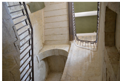
Fig. 41 - Logis, escalier d'honneur, vue depuis l'étage de soubassement (avant travaux).
