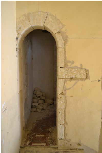
Fig. 52 - Logis, étage de soubassement, passage (travaux en cours).
