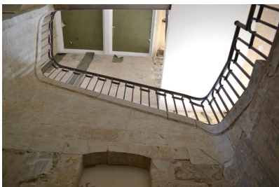
Fig. 40 - Logis, escalier d'honneur, vue depuis l'étage de soubassement (travaux en cours).
