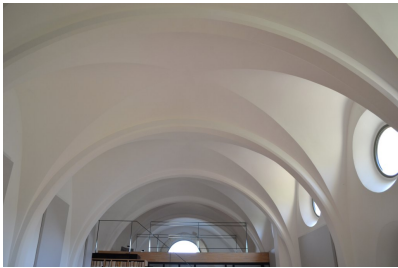
Fig. 64 - Chapelle, vue intérieure, détail des voûtes (après restauration).
