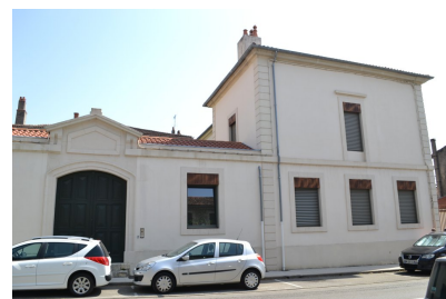
Fig. 3 - Façade sur rue, partie sud.
