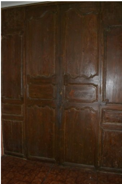
Fig. 31 - Logis, rez-de-chaussée, placard (avant travaux).
