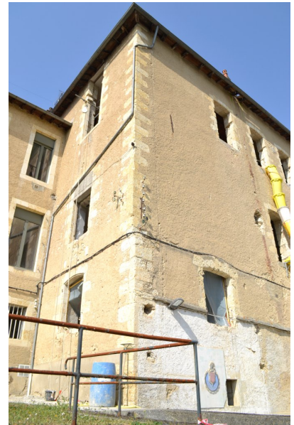
Fig. 18 - Logis, élévation postérieure, angle oriental (travaux en cours).
